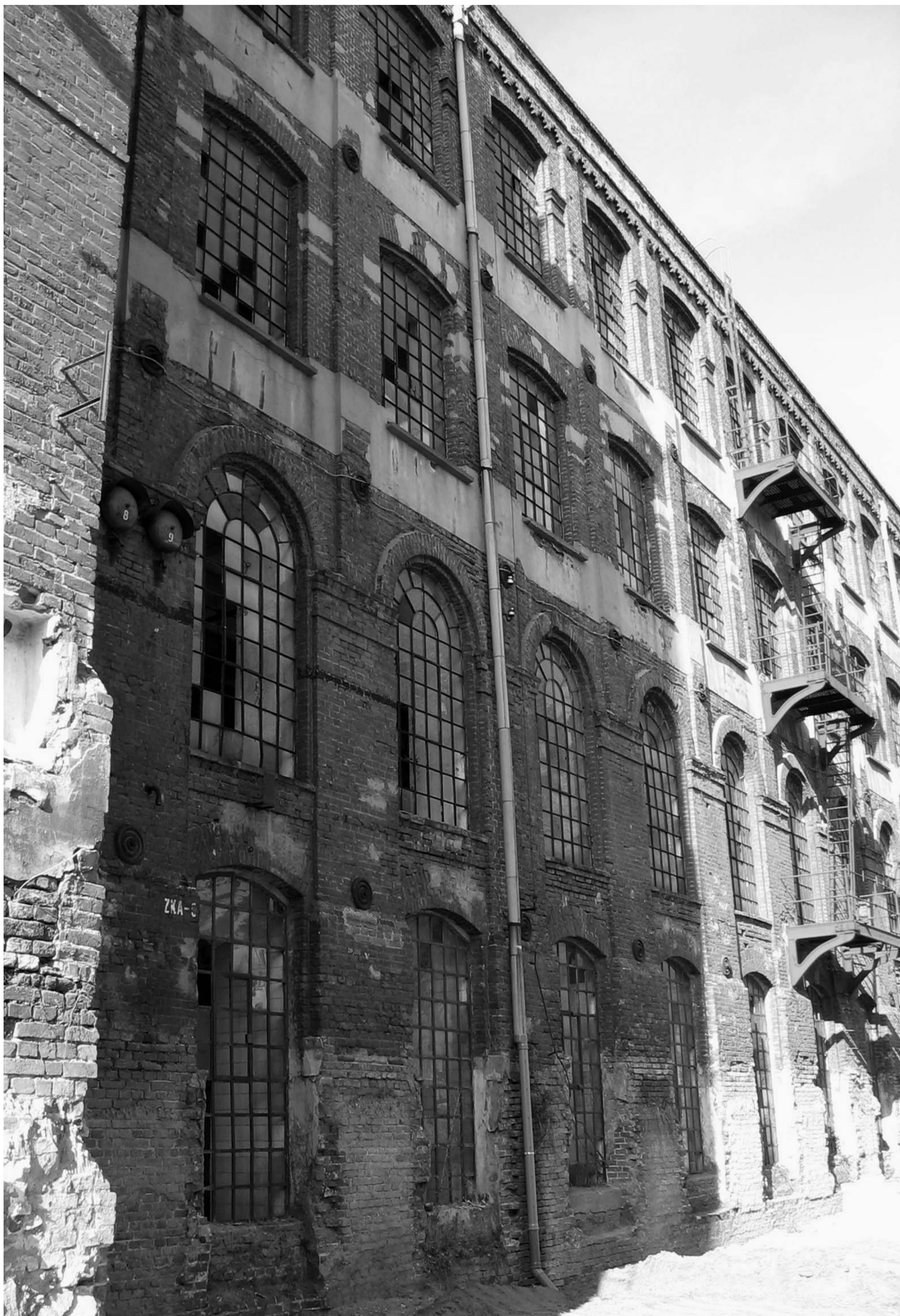
Widok nowego budynku Muzeum Sztuki w Łodzi w czasie prac adaptacyjnych, 2007, materiały prasowe MST.
